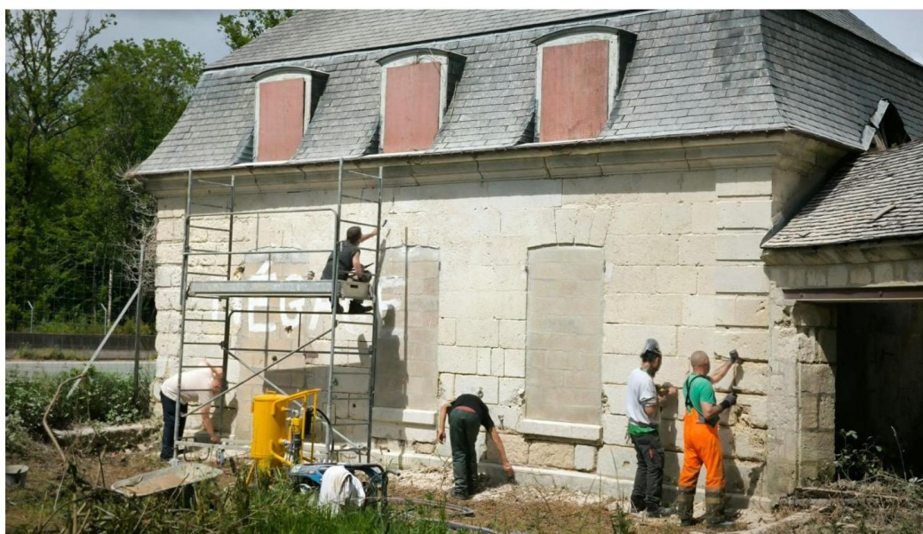
Un chantier d'insertion a permis dans un premier temps d'enlever les tags et de rejointoyer les pierres en attendant un diagnostic complet. Retz-en-Valois
