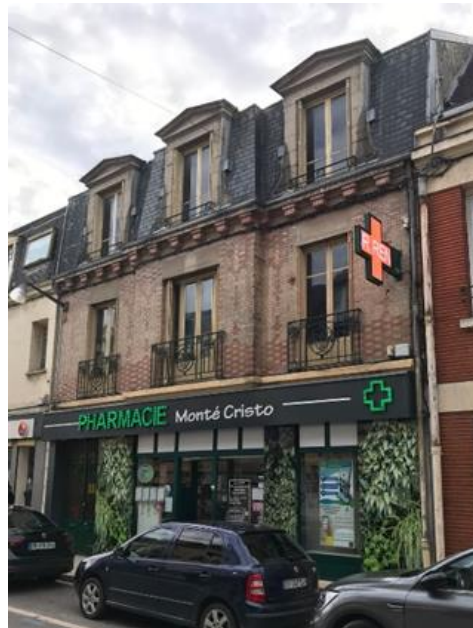
4 Rue du Général Mangin
